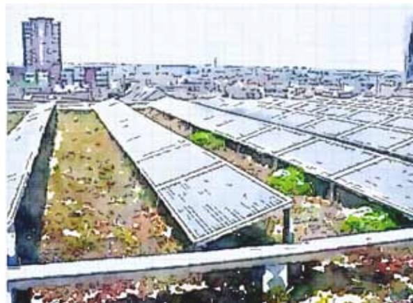
*Une surface de 150 m<sup>2</sup> de panneaux photovoltaïques sur le toit permettrait de fournir 20'000 kWh par an, couvrant ainsi 100% de la consommation électrique de l'ensemble des ménages.*
